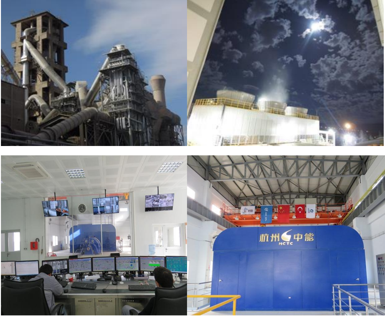
Atık Isı Tesisi
